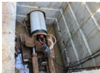
(e) 深基坑和地下管沟
