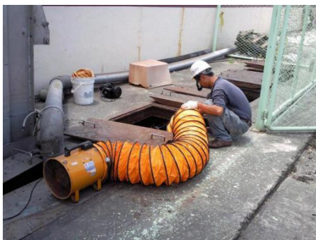
图 4-6 风机、风管的设置
